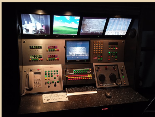
Рис. 3. Пульт представляет собой стол с органами управления и мониторами для вывода камер и служебной информации. Помощник режиссёра должен быть в курсе всего происходящего на сцене и за её пределами
